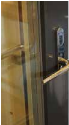
Ovilehti liikkuu vapaasti. Aukipitolaite ei lukossa.
